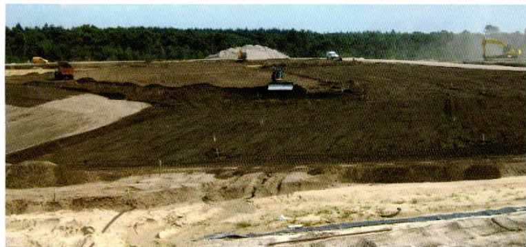
^ Om een beschermende laag aan te brengen op het vuil moet de afdicthting worden opgebouwd uit vier lagen.
