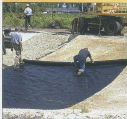
Werknemers van Van Helvoirt Groenprojecten BV rollen het worteldoek op de ondergrond van de vijver uit.
