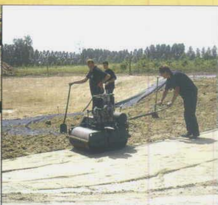
Nadat Trisoplast is aangebracht en met de schop verspreid, gaat de wals er overheen om het mengsel te verdichten.
