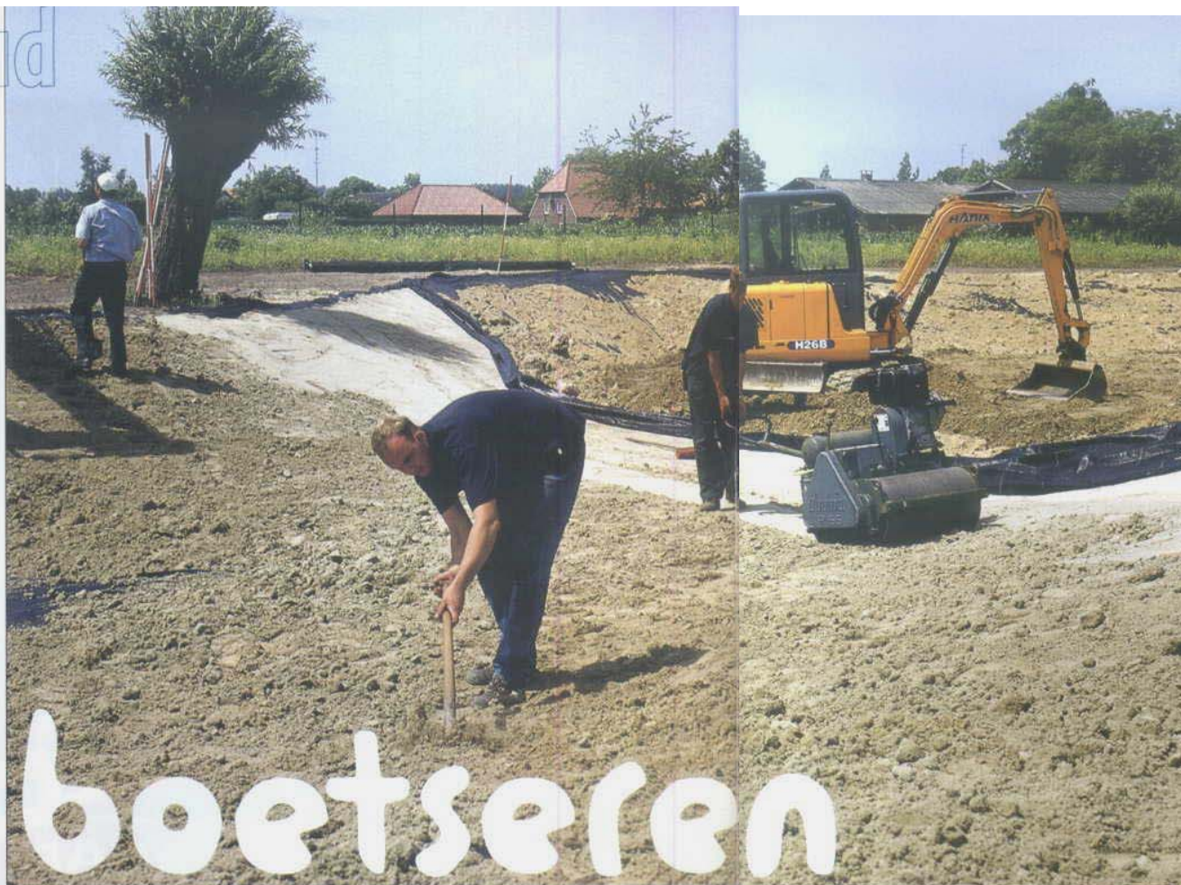
Met Trisoplast kan op eenvoudige wijze een waterdichte bodemlaag van grote vijvers aangebracht worden.
