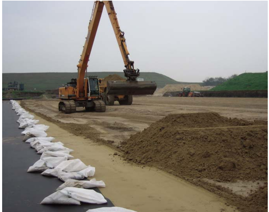
Figura 2. Sellado de un vertedero con Trisoplast
