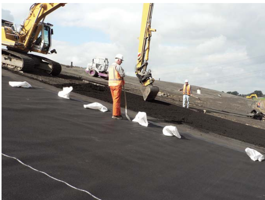
Figura 1. Sellado de un vertedero con Trisoplast y lámina de PEAD
