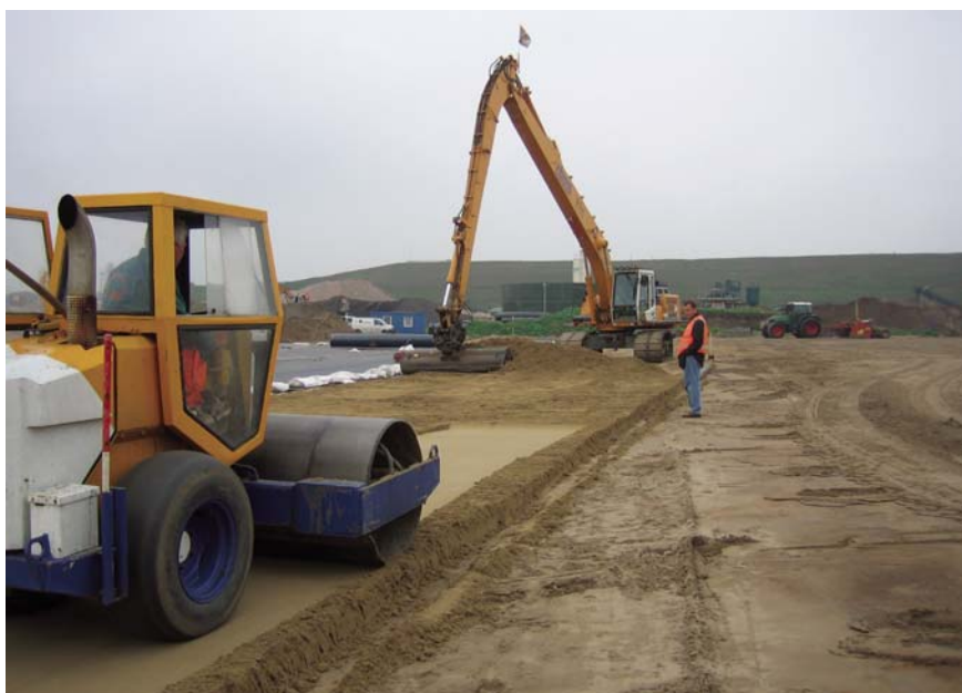
Figura 3. Extendido y compactación de Trisoplast
