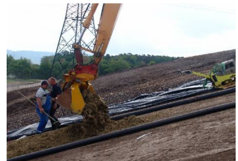
Probefeldbau im Mai 2006
