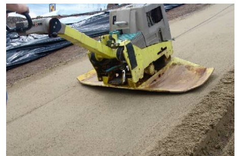
Verdichten von Trisoplast
