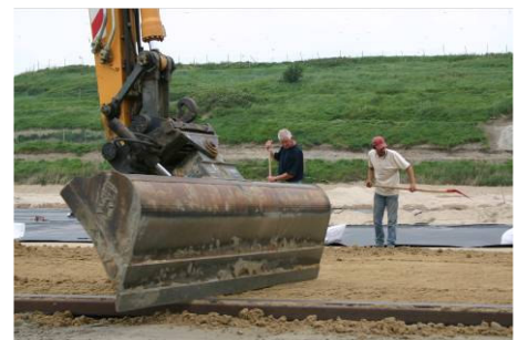
Bepaling van de juiste laagdikte is door gebruik van een afreibalk erg eenvoudig.
