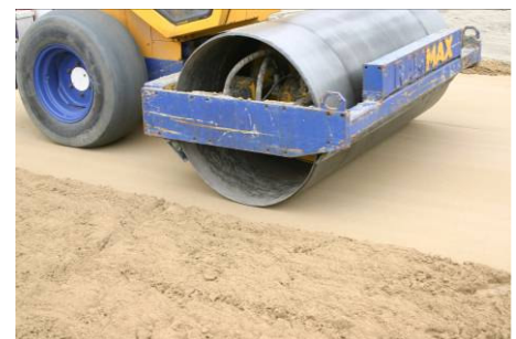
Verdichting van de laag door middel van een wals..
