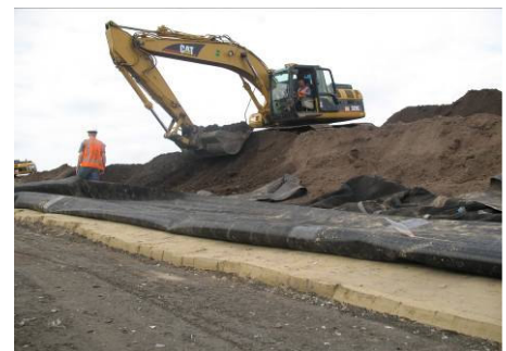
Trisoplast®-laag met daarop HDPE-folie, geo-textiel en drainagelaag.
