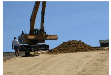
Einbringung Trisoplast
