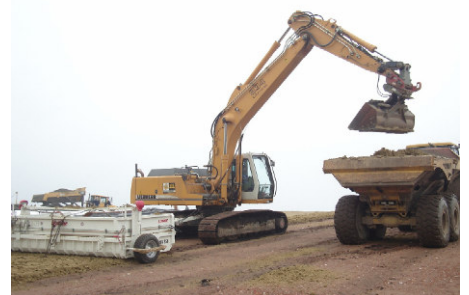
Verteilen von Trisoplast
