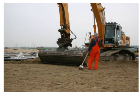
Handmatige meting van laagdikte.
