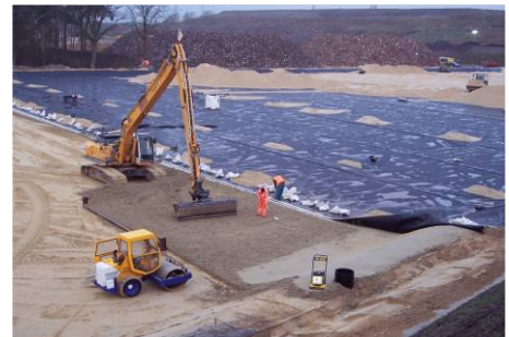
Aanbrengen van de Trisoplastlaag, verdichting met wals of trilplaat.
