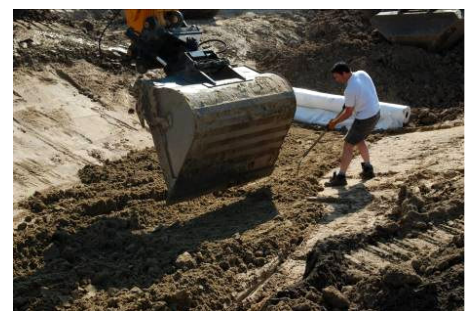
Handmatige meting van de laagdikte.
