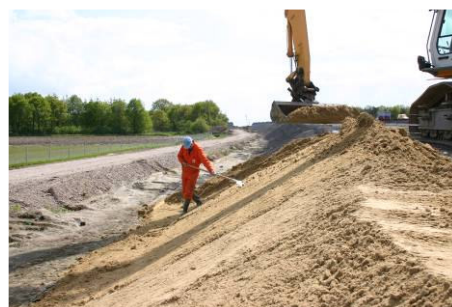
Het aanbrengen van Trisoplast op taluds.
