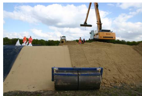
Eenvoudig te verdichten na aanbrengen.
