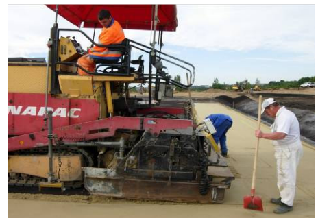
Einbau von Trisoplast mit Straßenfertiger
