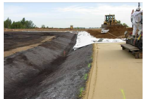
Dichtungsaufbau
