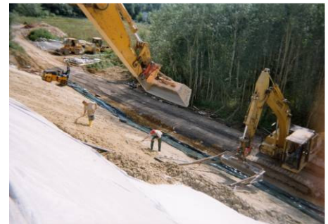
Spezialgerät an der Böschung
