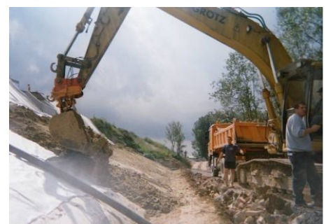
Einbau von Trisoplast
