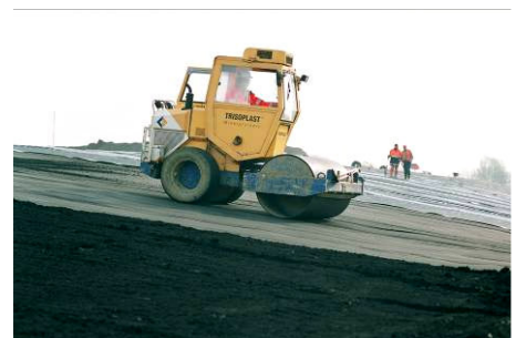
Verdichting op vlakke ondergrond of flauwe hellingen gebeurt d.m.v. een wals.
