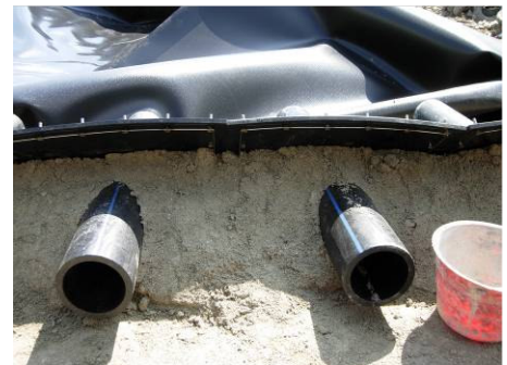
Einbindung von Rohrleitungen
