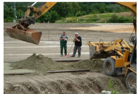
Verteilen des Trisoplast Mischgutes
