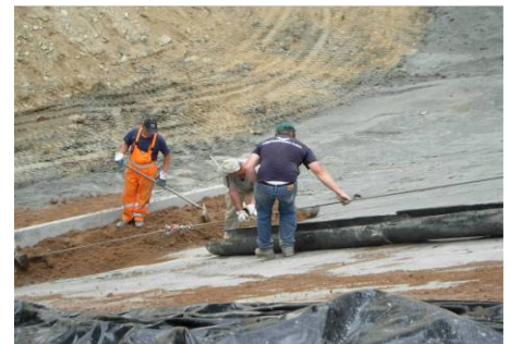
Einbringung in das steile Baufeld (1:1,5)
