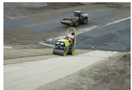
Leichte Verdichtung von Trisoplast
