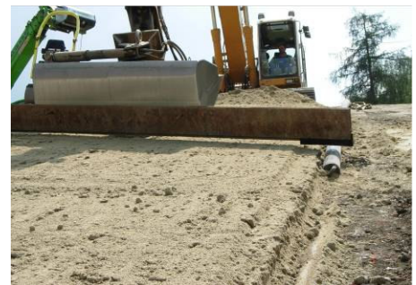
Einbau von Trisoplast
