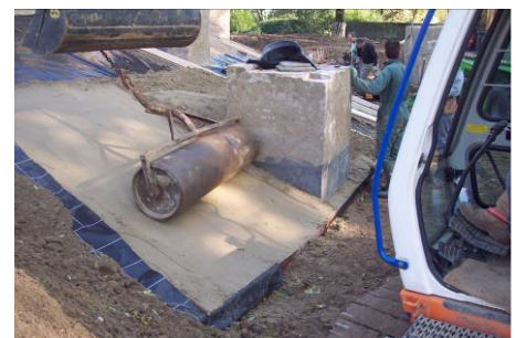
Het verdichten van Trisoplast op taluds.
