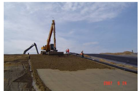
Ook op hellingen eenvoudig aan te brengen en te verdichten.
