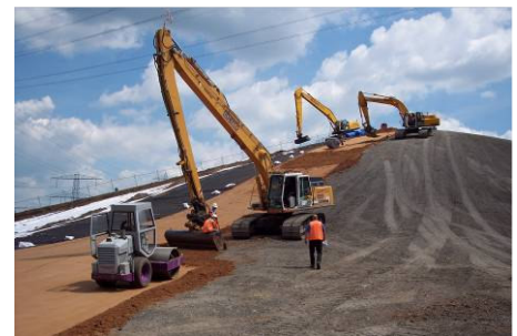
Aanbrengen en verdichten van de Trisoplast, op vlakkere delen m.b.v. een wals.
