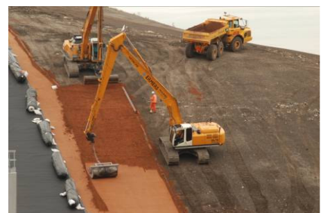
Verdichting op steile hellingen gebeurt d.m.v. een walsrol.
