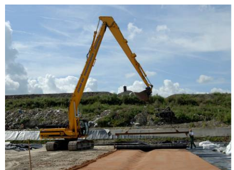
De verdichte Trisoplastlaag wordt afgedekt met een HDPE folie.
