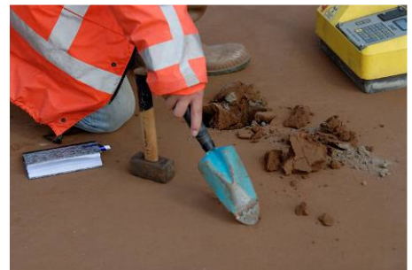
Kwaliteitscontrole van de verdichte laag door een onafhankelijke instantie.
