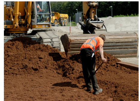
Aanbrengen van de Trisoplast en meten van de laagdikte.
