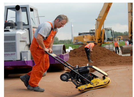
Verdichting van moeilijk bereikbare plaatsen zoals sleuven d.m.v. een trilplaat.
