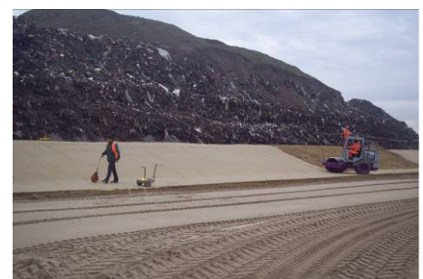
Kwaliteitscontrole na verdichting.
