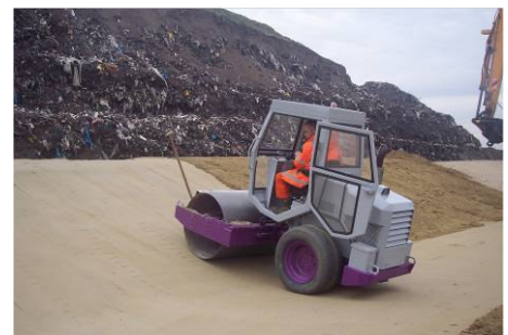
Verdichting van de zojuist aangebrachte Trisoplastlaag.
