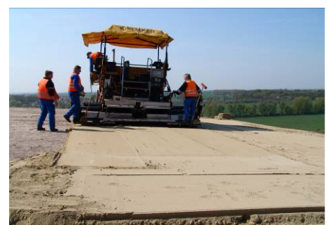
Einbau von Trisoplast mit Straßenfertiger
