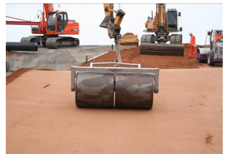
Verdichting op steile hellingen middels een kraan met walsrol.
