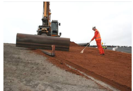
Handmatige controle van de laagdikte
