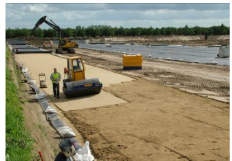
Verdichting van de Trisoplastlaag.
