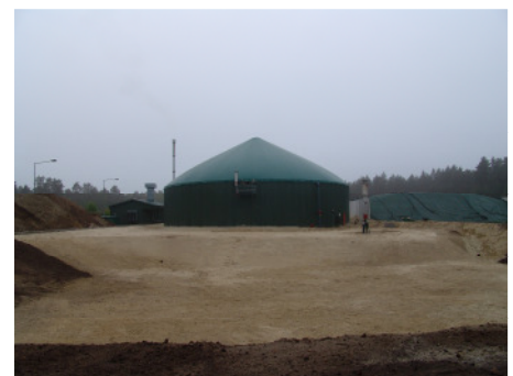
Havariefläche mit angrenzendem Rückhaltebecken
