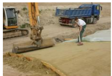
Verdichten von Trisoplast oberhalb des Dichtwandkopfes
