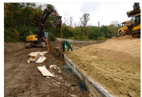
Dichtwandkopfeinbindung
