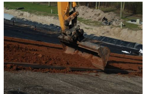
Aanbrengen van Trisoplast in juiste onverdichte dikte d.m.v. een afreibalk
