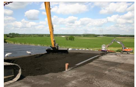
De zwarte kleur is het gevolg van het gebruik van zwart vormzand.
