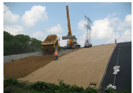
Aanleg gebeurt in banen met een breedte gelijk aan die van de afdekkende folie
